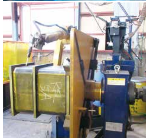
仕口用溶接ロボット
