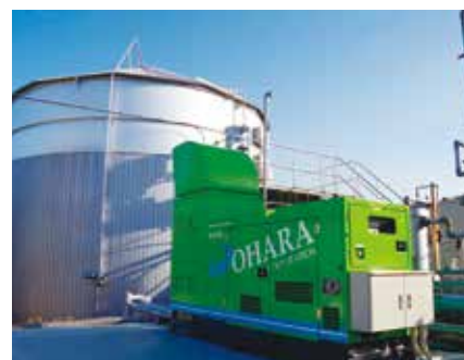
食品加工残渣由来のバイオガスで稼働中の発電システム
