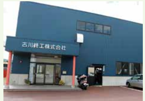
古川機工(株) 本社
